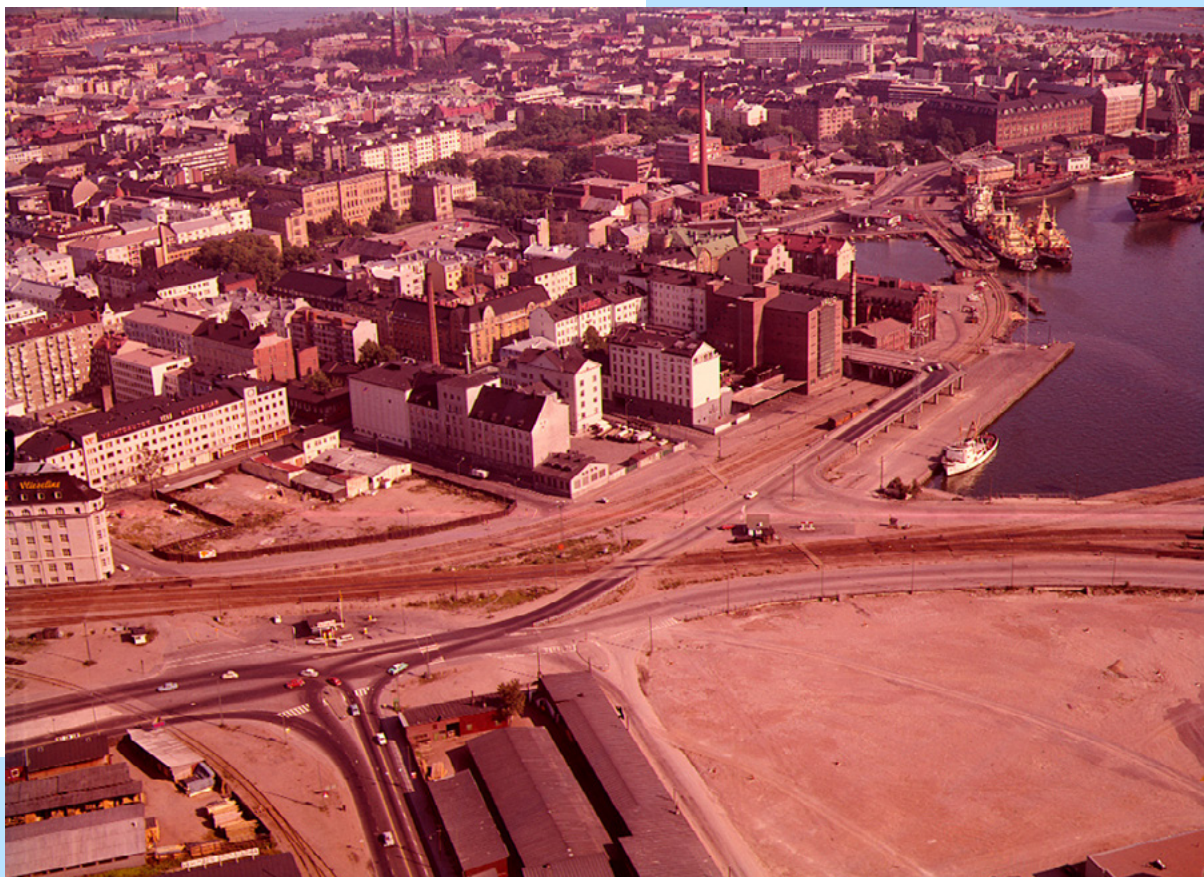
Kuva 10. Helsinki oli vielä 1960 koko maan mittakaavassa merkittävä teollisuuskaupunki, mutta seuraavien 20 vuoden aikana teollisuuden työpaikkojen määrä väheni yli 50 prosentilla. Hietalahden- ja Ruoholahdenrannan teollisuus- rakennusten rivistö oli uhanalainen 1970-luvulla. Korttelin keskelle jäi lopulta pieni Theodor Höijerin piirtämä makasiini. Muutoin niin sanotun Kirjatalon korttelin tuotantorakennukset purettiin 1984 suojeluyrityksistä huolimatta. Rikkaasti profiloitu, punatiilinen Kirjatalo (ent. puusepantehdas, Grahns, Hedman & Wasastjerna, 1895) korvattiin 7-kerroksisella asuinrakennuksella. Viereisessä korttelissa Valion juustovarasto (Maunu Siitonen, Jerro Laasmaa 1941, 1955) sekä entiset kemiantutkimussäätiön ja Valion laboratoriot säilyivät, ja ne muutettiin 1990-luvun alussa hotelliksi. Kuva: AD-museo.
